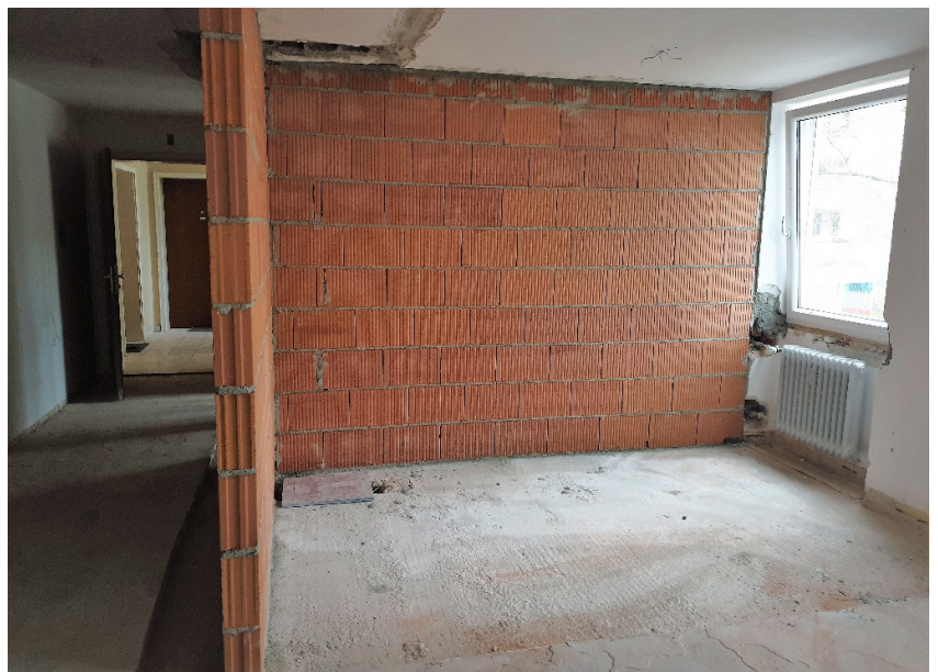
und bereits wieder aufgemauert
